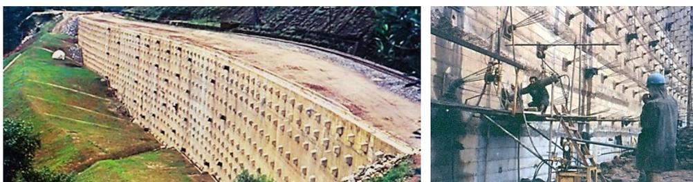
Figura 5. Vista da cortina atirantada concluída (esquerda) e a colocação das células de carga (direita).
